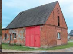
Alt + neu: Das alte Gerätehaus war nicht mehr zu retten. Im schmucken Anbau am sanierten Gemeindefeuerhaus steht der MTW.
